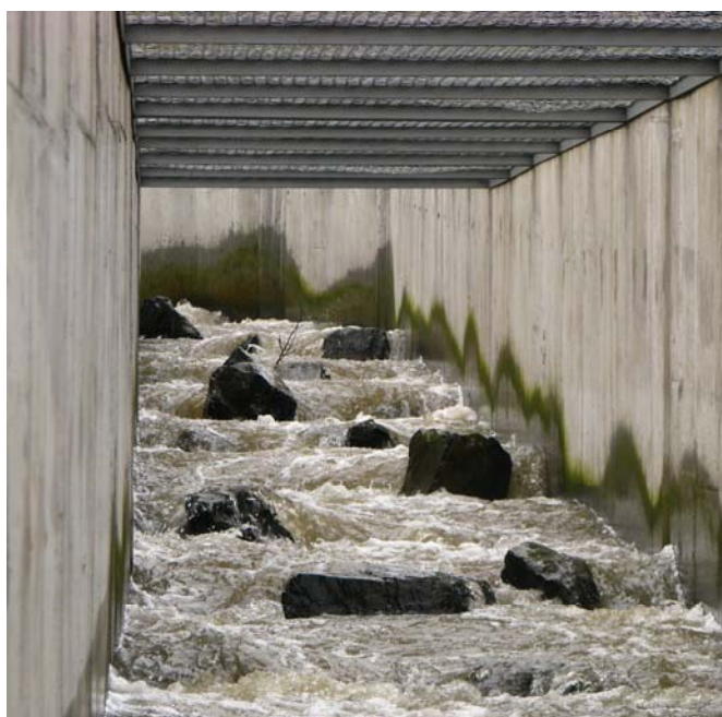
Fot. 2. Wnętrze przepławki – widoczne kamienne rygle (Fot. J. Ligęza).
