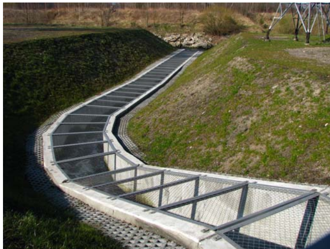
Fot. 1. Widok dolnego odcinka przepławki przy stopniu wodnym Bukówka, w miejscowości Bucze (Fot. J. Ligęza).
