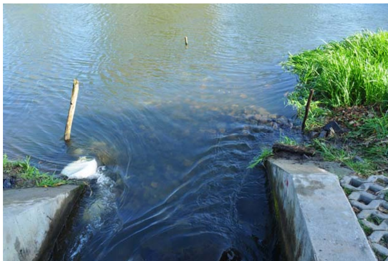
Fot. 3. Narzut kamienny ograniczający dopływ wody do przepławki po jej modernizacji (Fot. M. Adamczyk).
